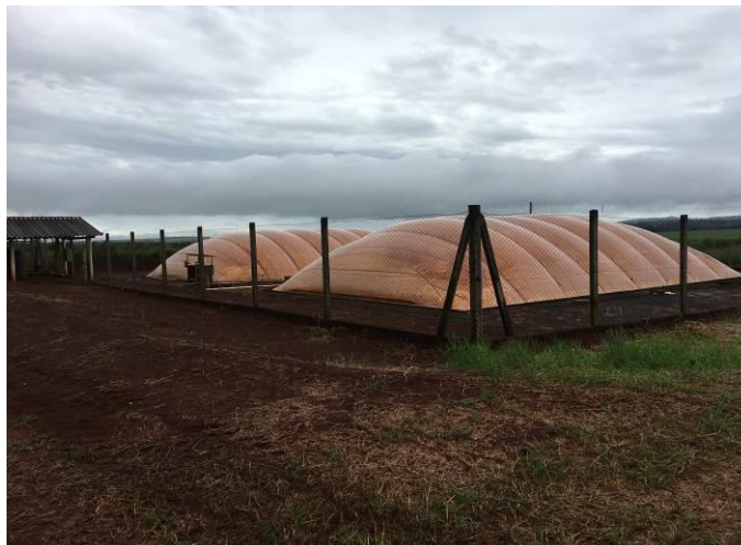
Figura 12 – Biodigestor para produção de biogás
