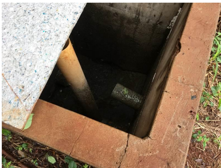
Figura 13 – Caixas de inspeção de dejetos
