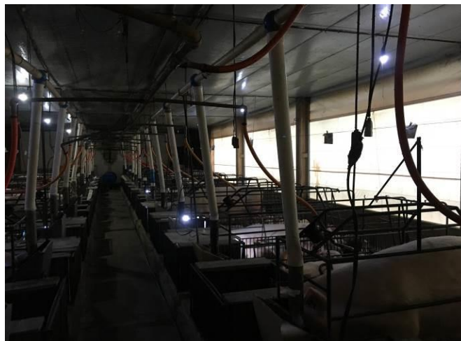
Figura 7 – Sistema de aquecimento
