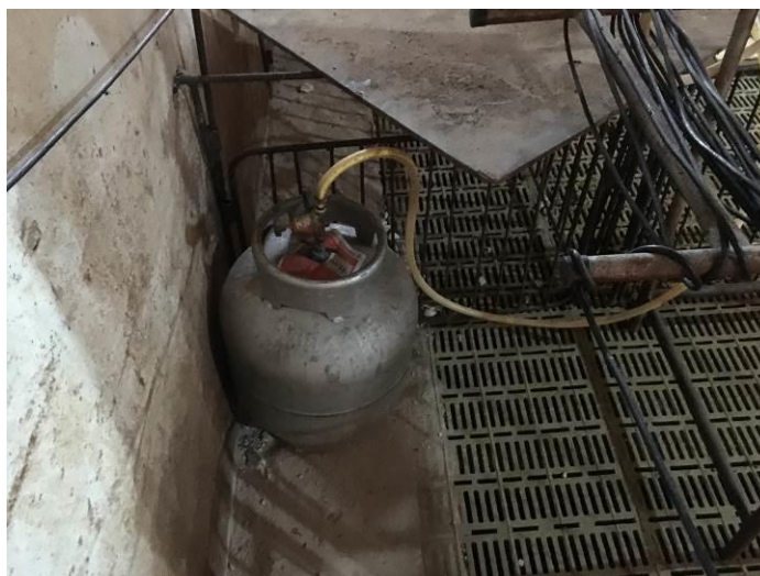
Figura 8 – Sistema de aquecimento a gás
