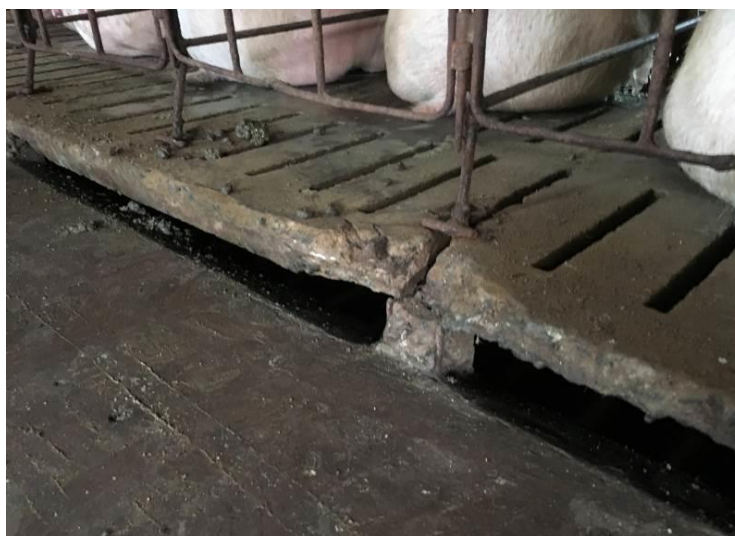
Figura 4 – Piso quebrado na gestação
