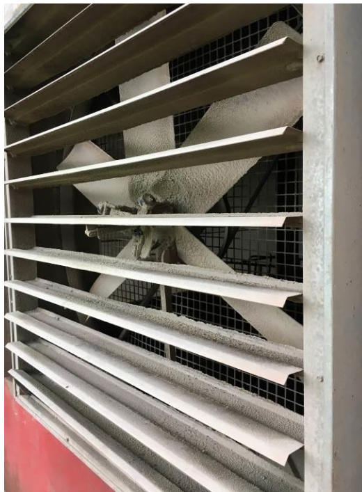
Figura 6 – Exaustor sem proteção
